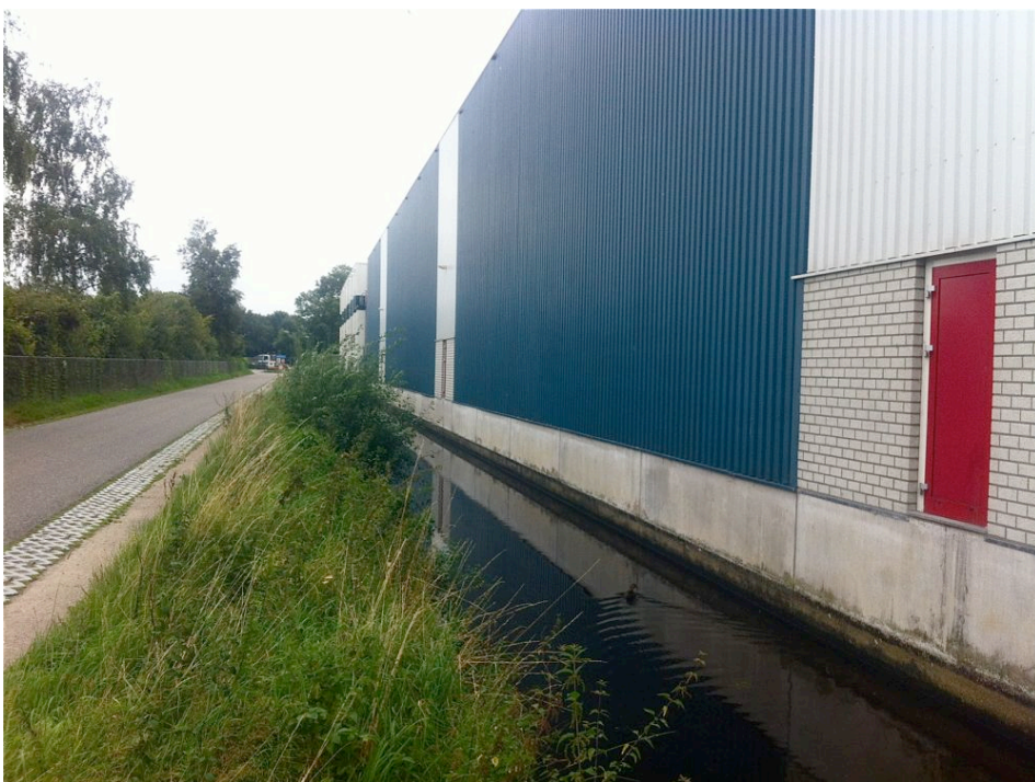
Foto 2 Afwateringsloot langs De Nort, noordkant.
