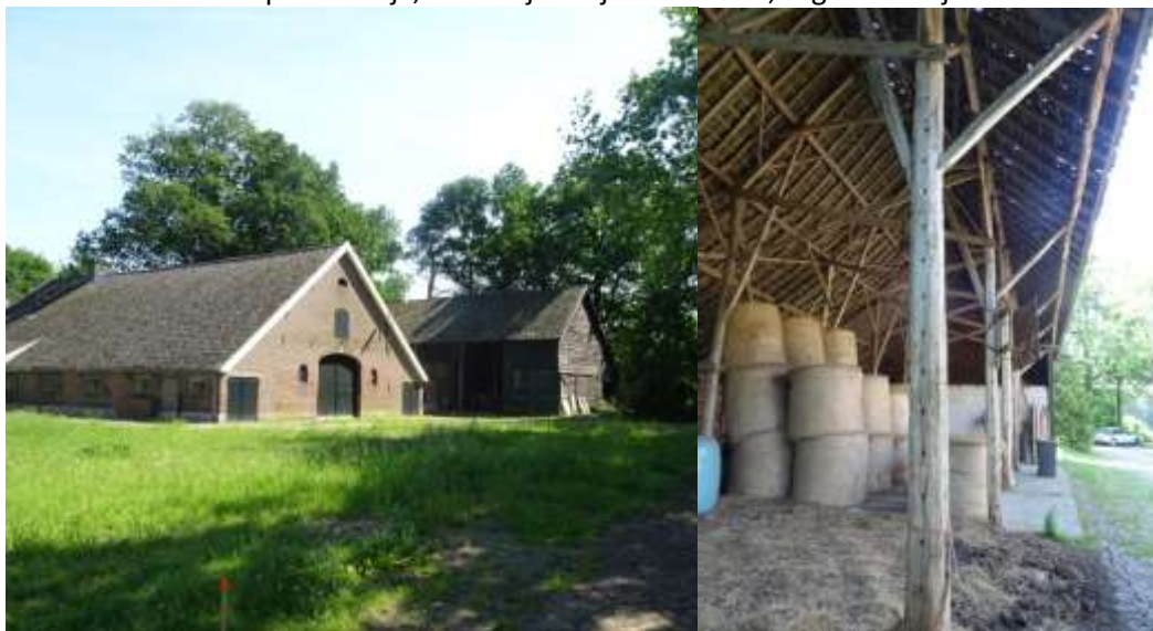
Afbeelding 5: de bestaande hoeve met bijbehorende houten kapschuur
