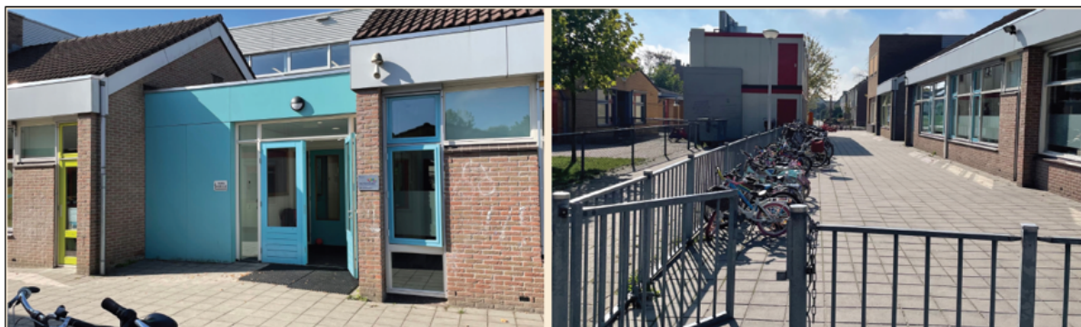
Links: bestaande hoofdentree, rechts: tussenzone met fietsparkeren en noodlokalen (bron: Arcom Partners B.V.)
