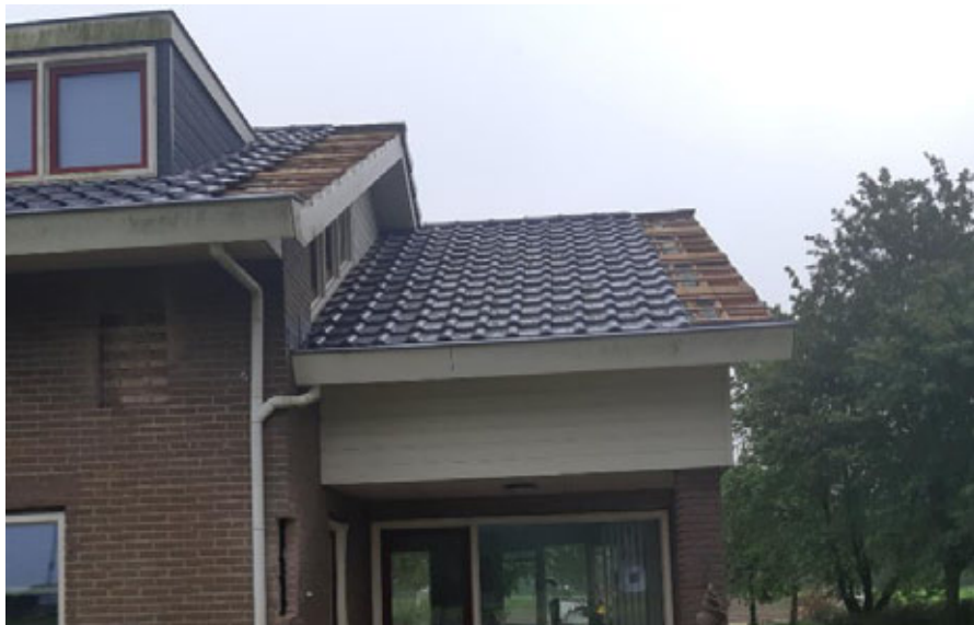
Figuur 3.1 Ongeschikt maken woning door het maken van tochtgaten (boven) en verwijderen kantpannen (onder). Kozijnen dienen hier nog verwijderd te worden.
