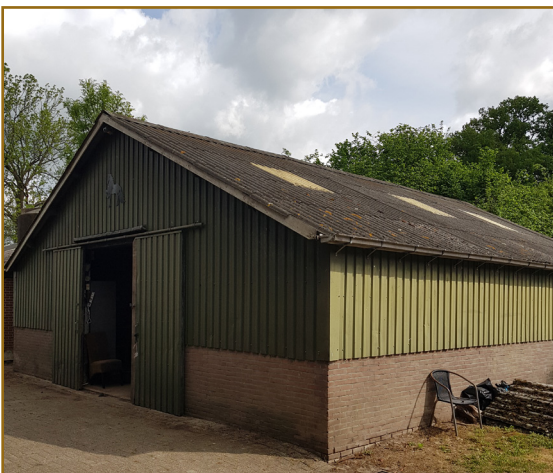
Afb. 2.9: Overzichtsfoto van schuur 4 met de metalen wandbeplating.
