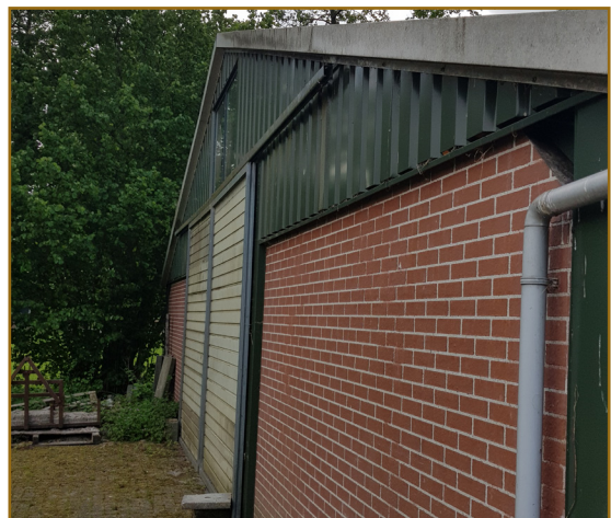
Afb. 2.10: Foto van schuur 5 met de metalen wandbeplating.
