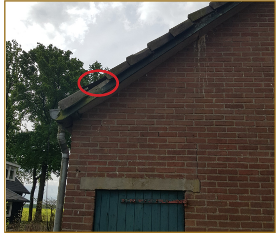
Afb. 2.2: Plaats van een spreekwennest (rode cirkel) aan de noordzijde van schuur 2.
