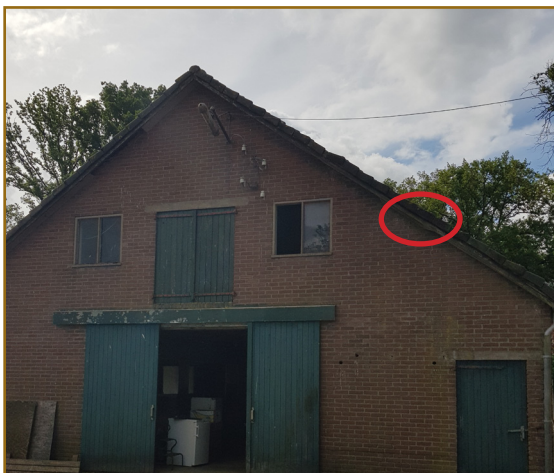
Afb. 2.3: Plaats van een spreekwennest (rode cirkel) aan de noordzijde van schuur 2.
