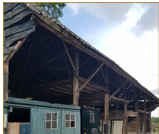
Afb. 2.6: Overzichtsfoto van het achterste deel van schuur 3.
