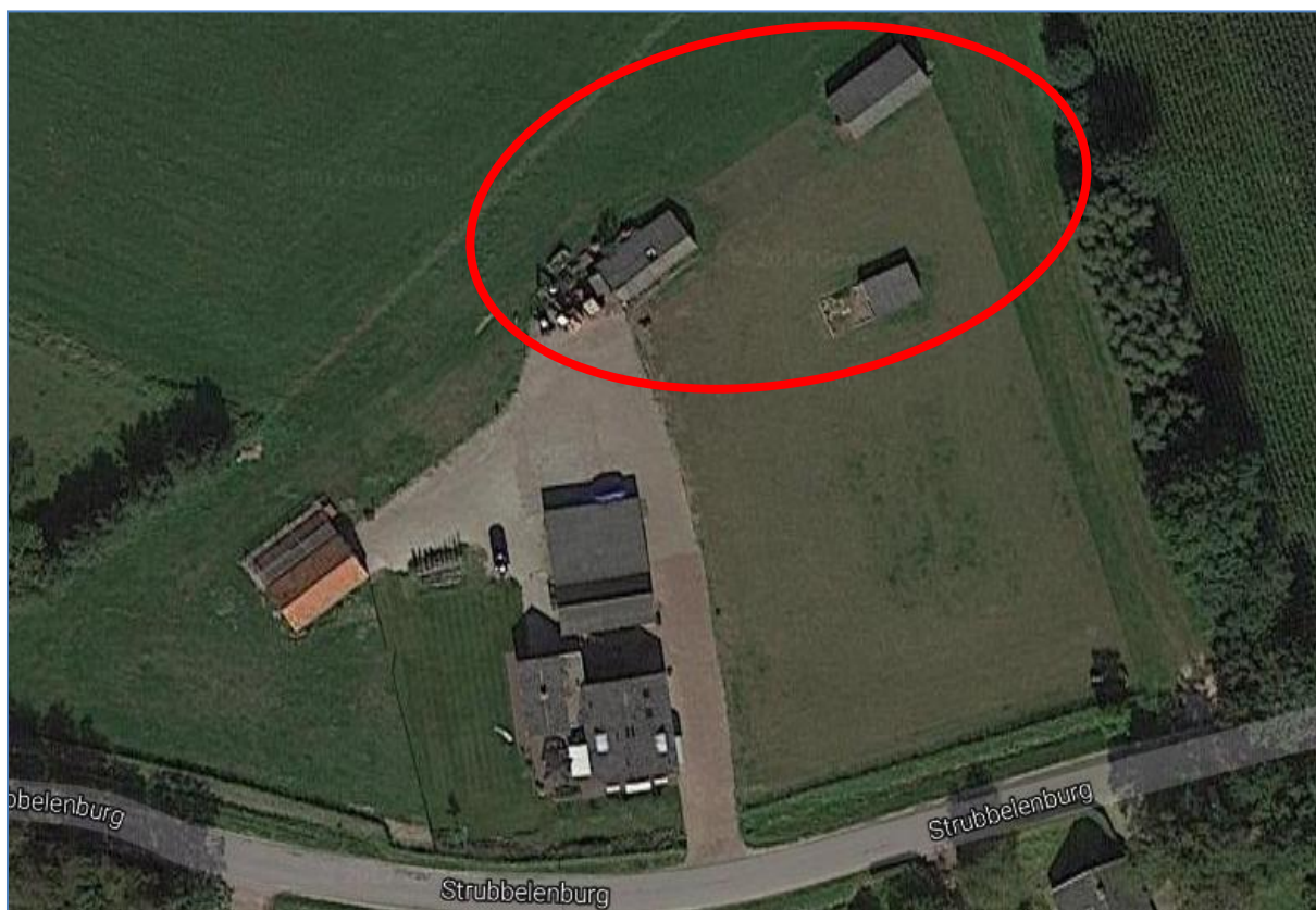
Luchtfoto perceel Strubbelenburg 13 met te slopen bedrijfsbebouwing rood omcirkeld
