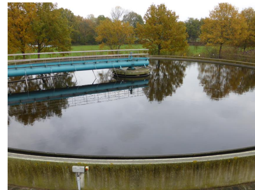
figuur 47 Nabezinktank op RWZI Woudenberg
