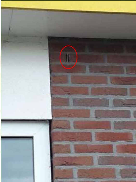
Bijenbekjes in stootvoegen, goed afgewerkte betimmering (bron: FF Solutions)
