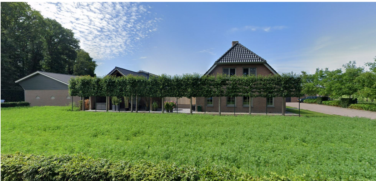
Aanzichten vanaf de Voskuilerdijk
