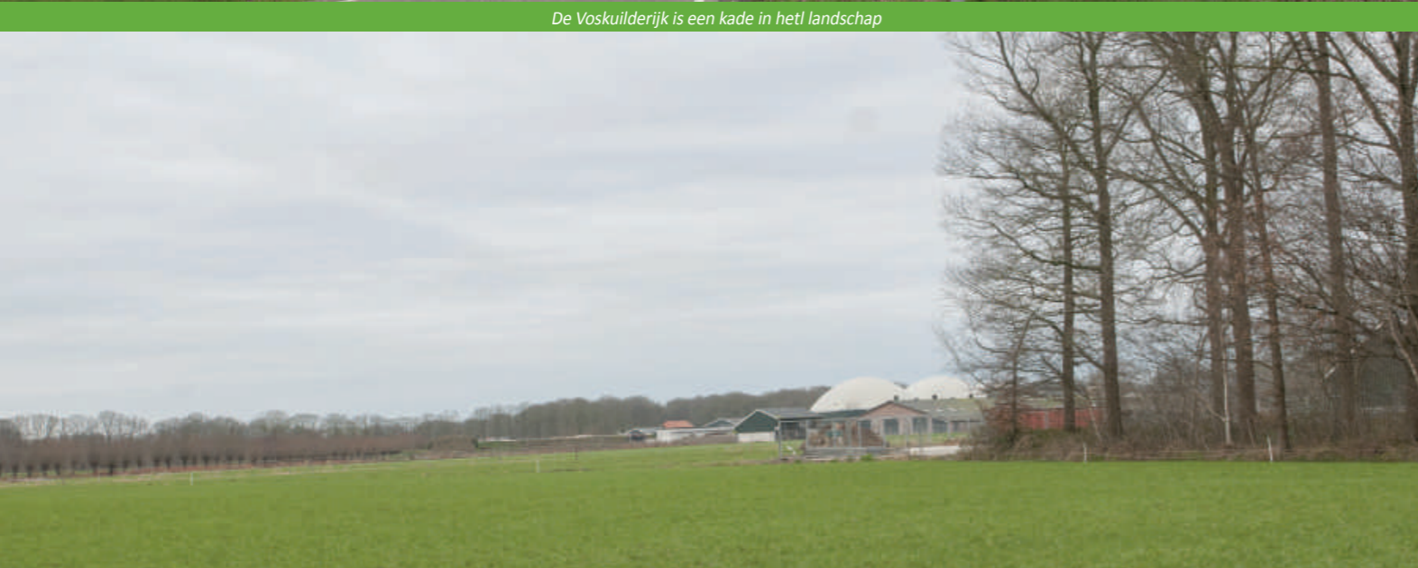
De huidige opslag en de biogas installatie is zichtbaar vanaf de Voskuilerdijk. Door het bestaande bos uit te breiden, aan de zuidkant van het erf, wordt dit aan het zicht onttrokken.
