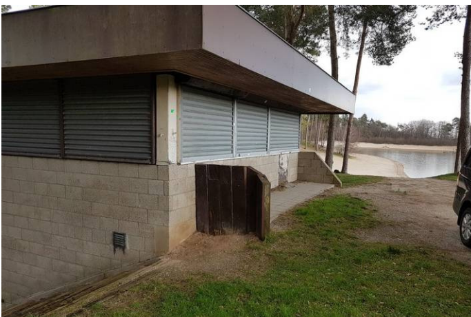
Locatie 3, foto 3 EHBO-post / toiletgebouw (vanaf westzijde)
