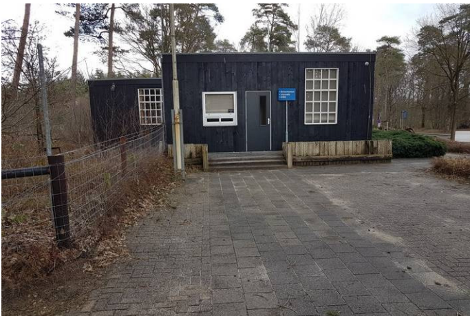
Locatie 5, foto 3: kantoor / clubhuis (vanaf zuidwestzijde)
