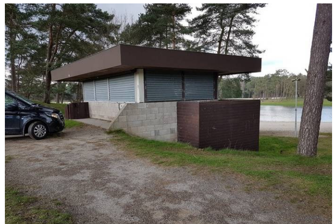
Locatie 3, foto 4 EHBO-post / toiletgebouw (zuidoostzijde)
