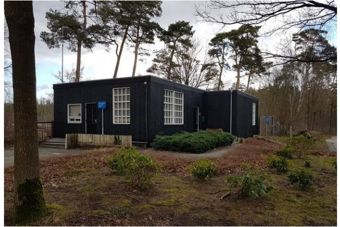
Locatie 5, foto 2: kantoor / clubhuis (vanaf zuidzijde)
