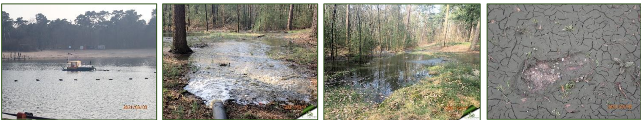
Figuur 9. [a] baggerwerken [b] tijdelijke inundatie duurt gemiddeld twee tot drie dagen na werken [c] dunne achterblijvende sliblaag
