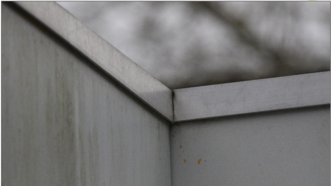
De daktrimmen van de gevel van de hal sluiten goed aan en er zijn geen openingen of kieren aanwezig. Foto: M. de Vries | Ecoresult B.V.
