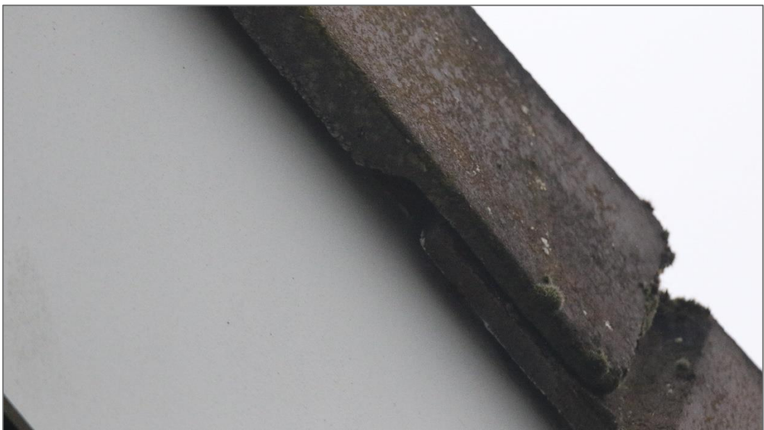
De overstekende kantpannen sluiten nauw aan er zijn geen openingen aanwezig waar gebouwbewonende vogels kunnen verblijven. Foto: M. de Vries | Ecoresult B.V.
