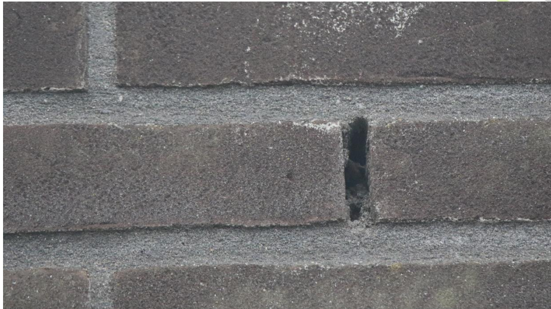
Figuur 7: In de noordgevel van de hal zijn 4 stootvoegen aanwezig met spinrag welke redelijkerwijs ongeschikt zijn voor gebouwbewonende vleermuizen. Foto: M. de Vries | Ecoresult B.V.
