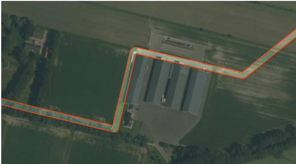
Gasleiding aangrenzend aan de planlocatie.
